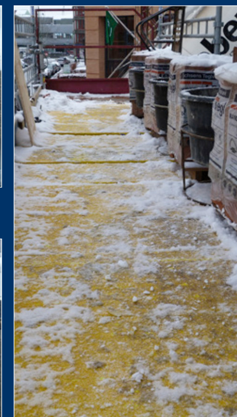
La banken opfylder alle belastningskrav til stilladsklasse 6.
