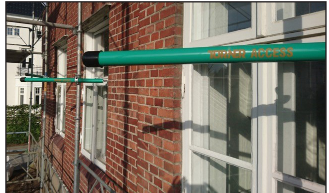
Den nyudviklede rørfastgørelse fra Nordic Platform består af komposit og er kendetegnet ved sin styrke og farvemulighederne. Her er det stilladsløseleverandøren Turner, som har valgt egen farve og firmanavn.
